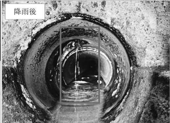
晴天時と降雨後の雨天時浸入水確認箇所
