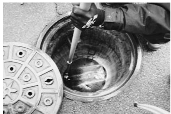
現場点検作業の様子
