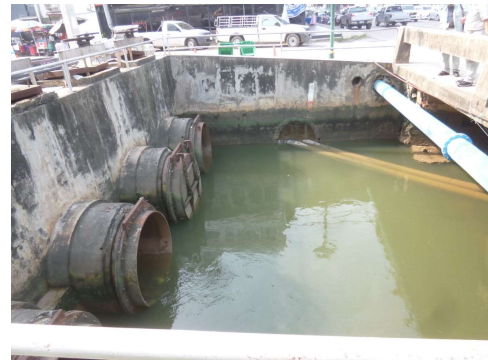
写真4 海に放流される未処理水 (ゲートが故障したまま)
