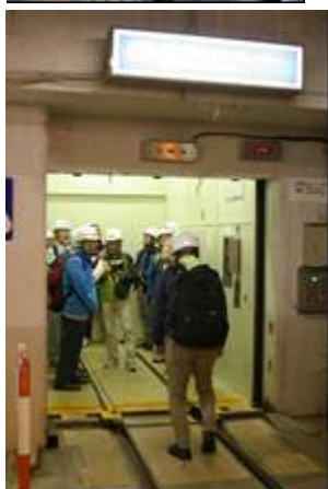
写真5 縦坑エレベータ(200m、車両1台も乗せることができる)
