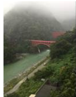
写真2 面影橋、新面影橋(奥)のトンネル
