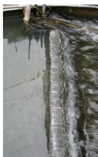
写真10 ①の広頂堰(水流(ナツプ)形状)
