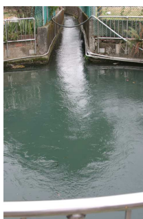
写真9 円堀への流入水路を見る
