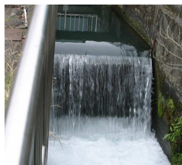
写真11 ②の全幅堰(刃型堰)
