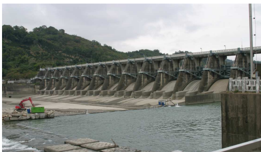
写真12 921石岡ダムの全景(写真左端が断層により沈下)
