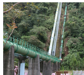
写真7 白冷圳の逆サイホン
