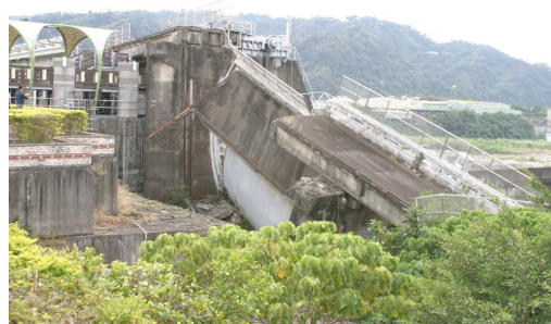
写真13 921地震による石岡ダムの崩壊痕の保存
